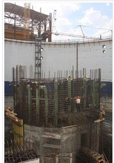
Kernfänger des Kernkraftwerk
